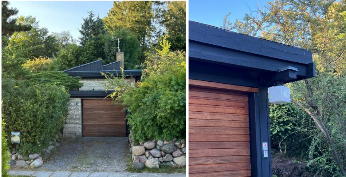
Billede carport og indgang mod syd før udbygning
